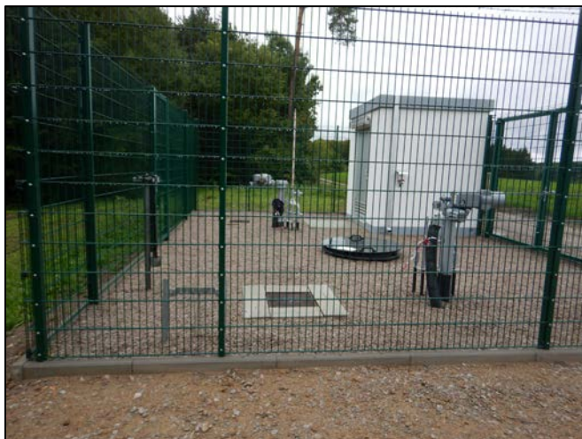
Abbildung 5 Beispielhafte Ausführung für die Armaturenstation; hier Armaturenstation Nordschwaben.
