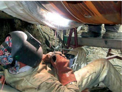
Die Schweißtechnik ist eine Schlüsseltechnologie für den Rohrleitungs- und Anlagenbau. Gut ausgebildetes Schweiß- und Schweißaufsichtspersonal gewährleistet die Qualität der Schweißkonstruktion durch die richtige Auswahl der Werkstoffe, Schweißprozesse und geeigneter Schweißeinrichtungen. Der Einsatz wirtschaftlicher Schweißtechnologien steigert die Effizienz der Fertigung.
